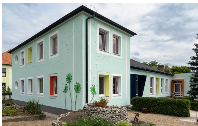
A dorogi Petőfi Sándor Óvoda homlokzati hőszigetelése
